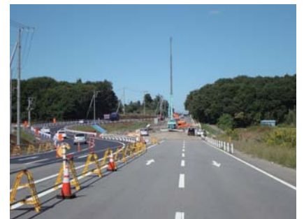
②つくば真岡線バイパスの道路改良工事の様子
