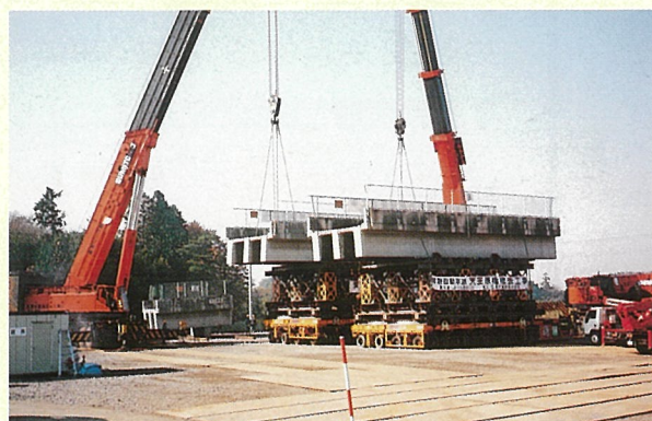
大型クレーンによる橋桁の吊り上げ状況
