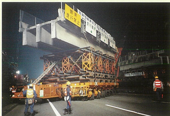
大型台車による橋桁の運び出し状況
