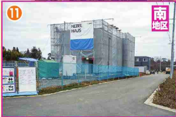
11 進む住宅建設
