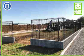
8 山中共同墓地周辺工事
