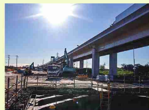
ご協力をお願いします 圏央道4車線化のための橋をつくっています 圏央道4車線化工事始まる! (つくばJCT周辺)
