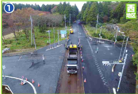
① 交差点改良工事 (堂山)
