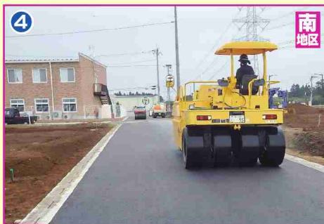
④ 道路舗装工事
