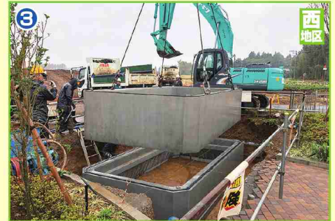
③ 防火水槽設置工事 (山中あみだ公園)
