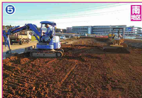
⑤ 宅地造成工事
