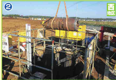
② 下水道整備工事
