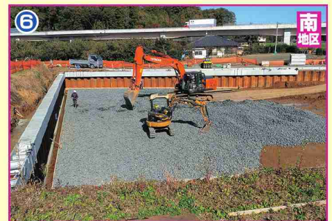
⑥ 調整池整備工事
