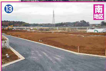
13 宅地整備工事
