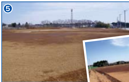
宅地造成工事
