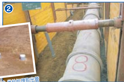
供給施設敷設工事
