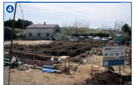
進む家屋新築工事
