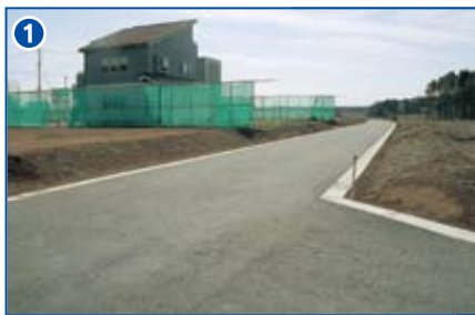
区画道路築造工事
