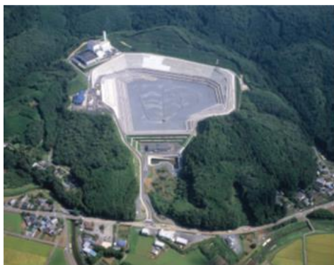
<整備された最終処分場（エコフロンティアかさま）>
