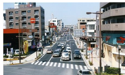
<電線地中化 整備後>
