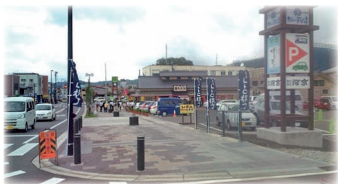
整備後の坂井四ツ谷線
