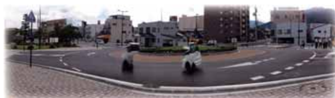
東和町ラウンドアバウト(新規整備 視認性重視の構造)
