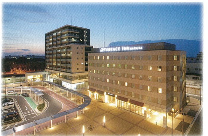
完成した東口駅前広場
