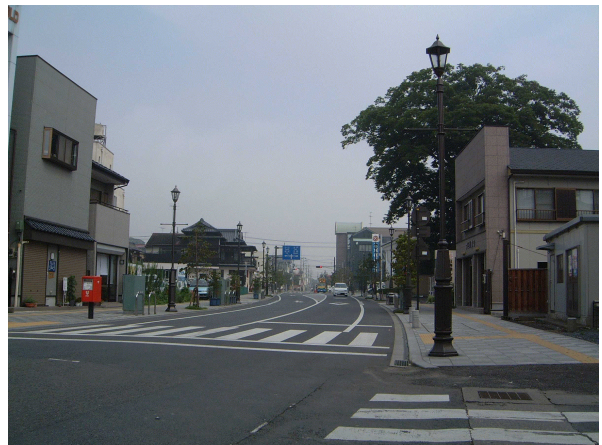
平成12年に完成した国道50号から下館駅に向かう約140mの車道拡幅・歩道設置区間
