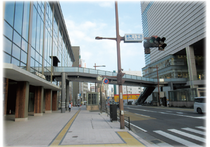
国道を跨ぐ上空通路
