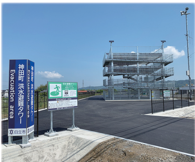
避難タワー全景
