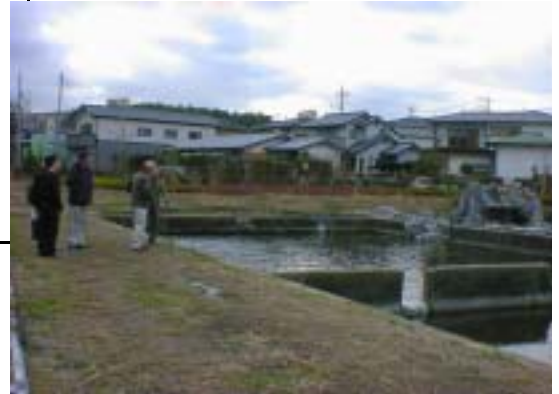
着々と工事が進む水木水公園
