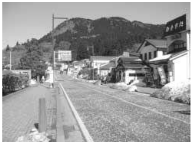
電線地中化により整備された街並み
