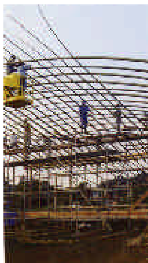
< 組み立て作業 >
