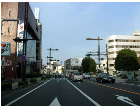
【国道6号の無電柱化（日上市）】
