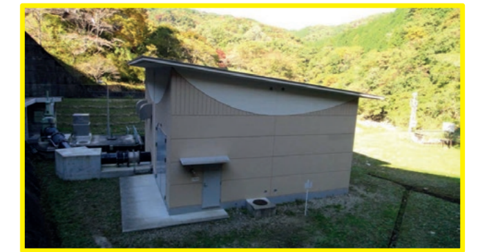
管理用発電所 外観
