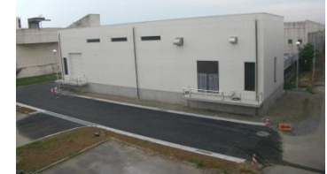
減菌施設(塩素混和池)
