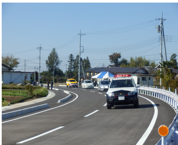
渡り始めの様子
