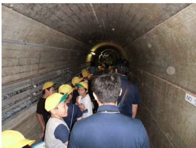
ダムの中（監査廊）
