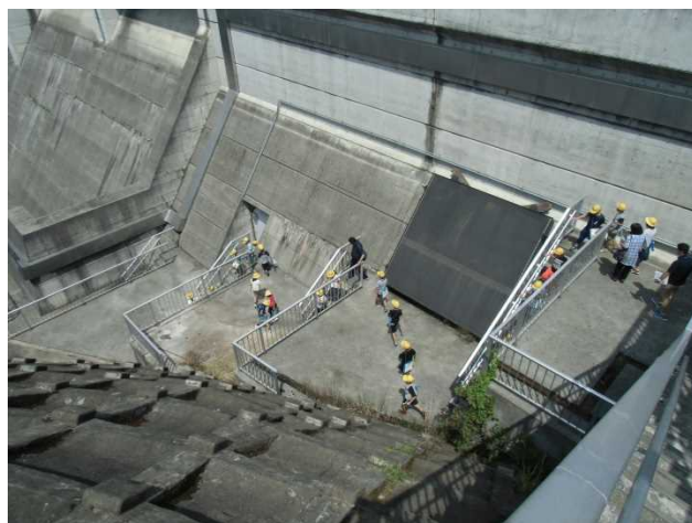
ダムの中（監査廊）へ向かう
