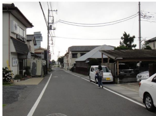
整備前の状況(歩道がなく、狭い道路)
