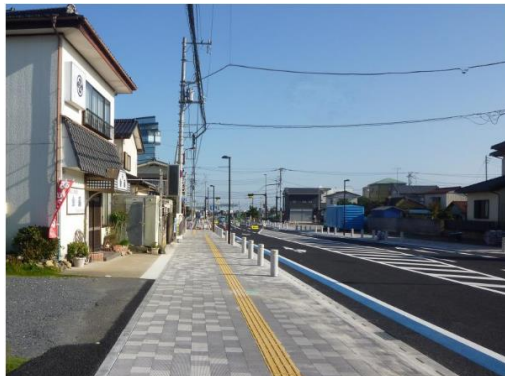
整備後の状況(広く歩きやすい歩道)
