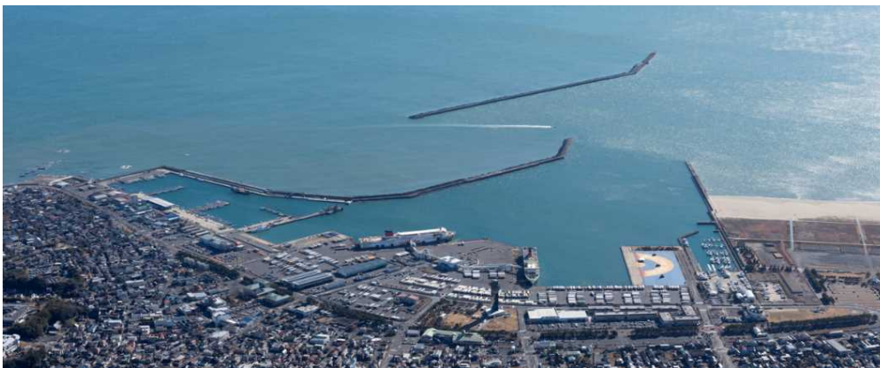
防波堤（大洗港区）
