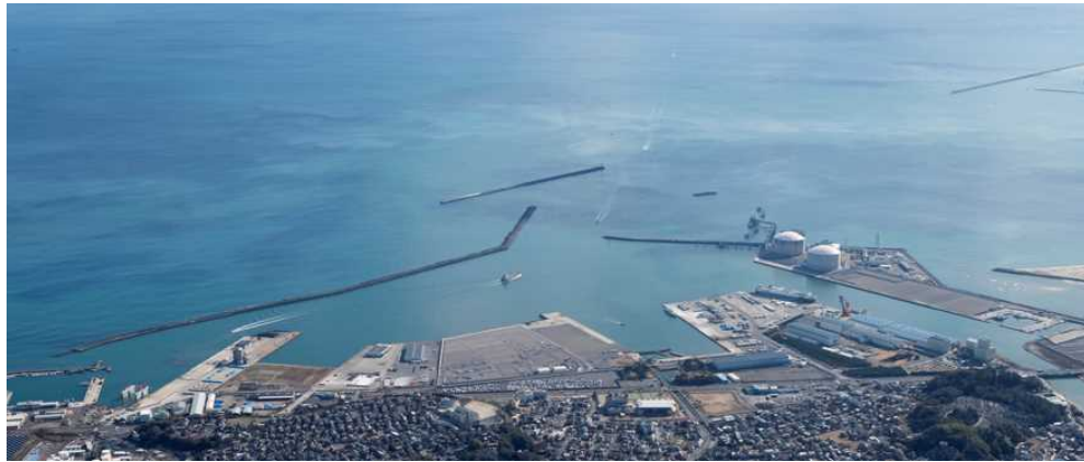
防波堤（日立港区）
