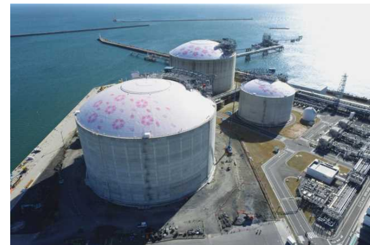
LNG基地 2号タンク令和3年3月より運転開始 (東京ガス(株)HPより引用)
