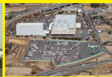
輸入車の新車整備センター
