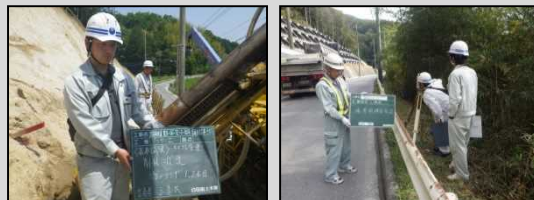
道路拡幅工事の立合い状況
