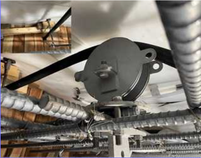
天端巻取り式バイブレーターセット状況
