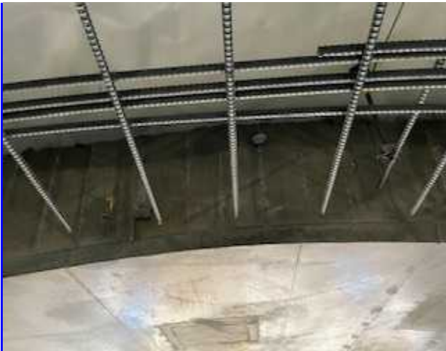
天端部の覆工コンクリート脱型状況
