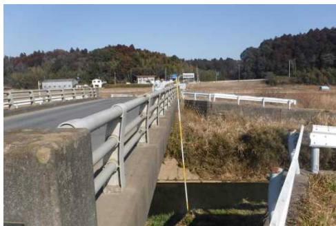
重要水防箇所の巡視
