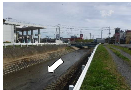
対策後(土砂除却後)
