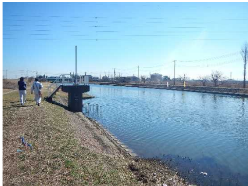
重要水防箇所の巡視
