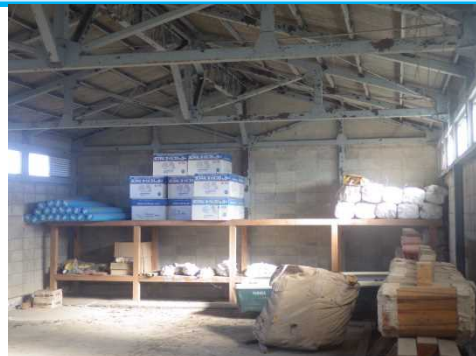
茨城県土浦土木事務所水防倉庫
