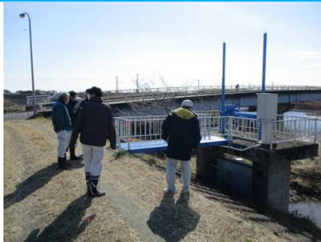
重要水防箇所の巡視
