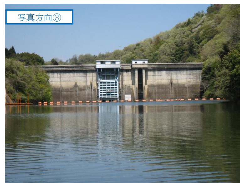
藤井川ダム状況写真
