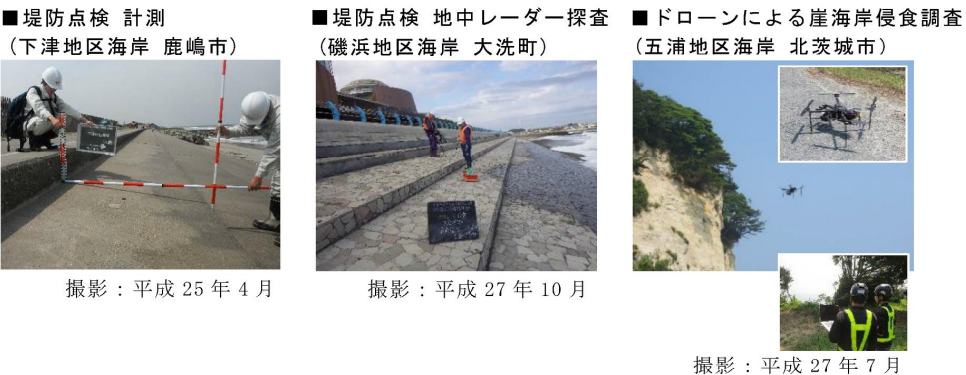
写真 3.8 堤防点検, 崖海岸侵食調査の様子
