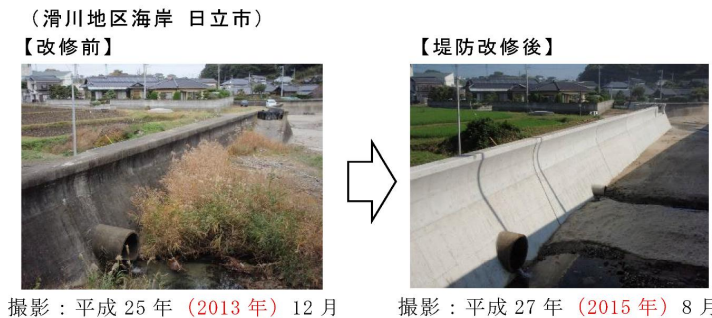
写真 3.9 堤防改修の例
