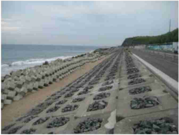
写真 2.22 消波ブロックが置かれた海岸
