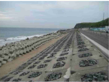
写真 2.22 消波ブロックが置かれた海岸
