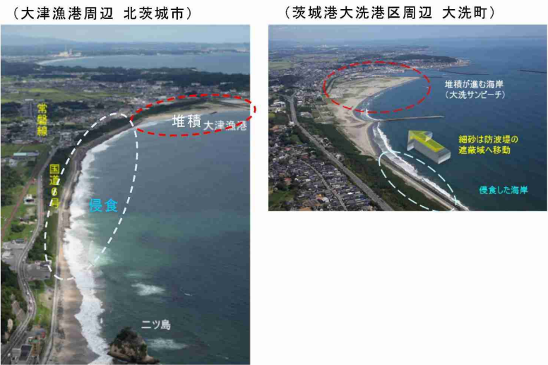
写真 2.8 大規模構造物周辺の堆砂と侵食
