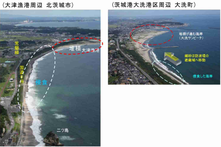
写真 2.8 大規模構造物周辺の堆砂と侵食
