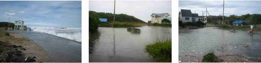
写真 2.6 異常潮位時の越波、浸水状況
