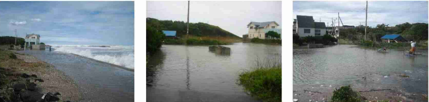
写真 2.6 大洗港最高潮位時の越波、浸水状況
