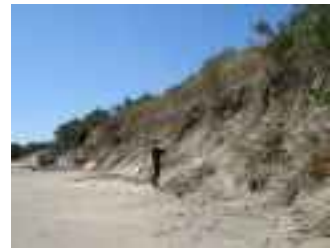
（多賀地区海岸 日立市）
