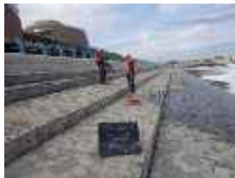
■堤防点検 地中レーダー探査 （磯浜地区海岸 大洗町）
