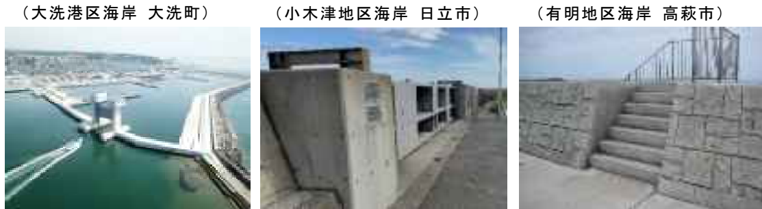
写真 3.10 水門・陸閘及び乗り越しタイプ階段の整備例
