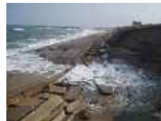
（荒野地区海岸 鹿嶋市）
