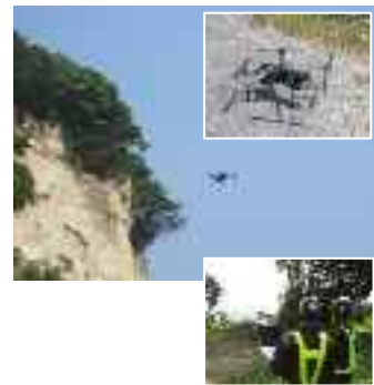
■ドローンによる崖海岸侵食調査 （五浦地区海岸 北茨城市）
