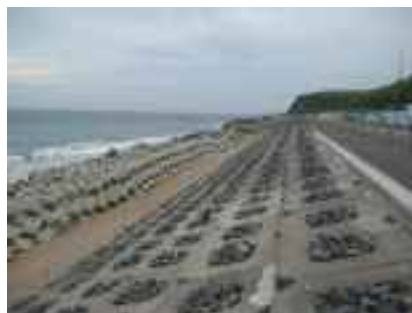
写真 2.22 消波ブロックが置かれた海岸
