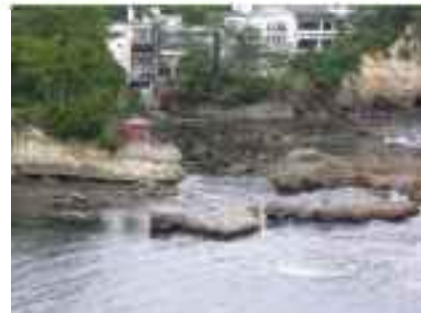
写真 3.15 観光施設（六角堂）に配慮した海岸保全施設の整備
