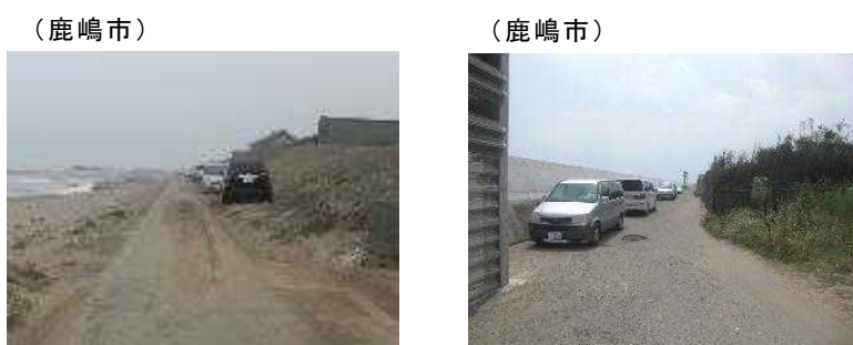
写真 3.21 管理用通路への違法駐車
