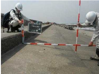
■堤防点検 計測 （下津地区海岸 鹿嶋市）
