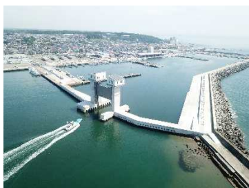
写真 3.10 水門・陸閘及び乗り越しタイプ階段の整備例
