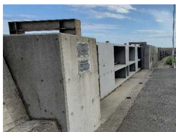
写真 3.10 水門・陸閘及び乗り越しタイプ階段の整備例
