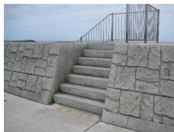
写真 3.10 水門・陸閘及び乗り越しタイプ階段の整備例
