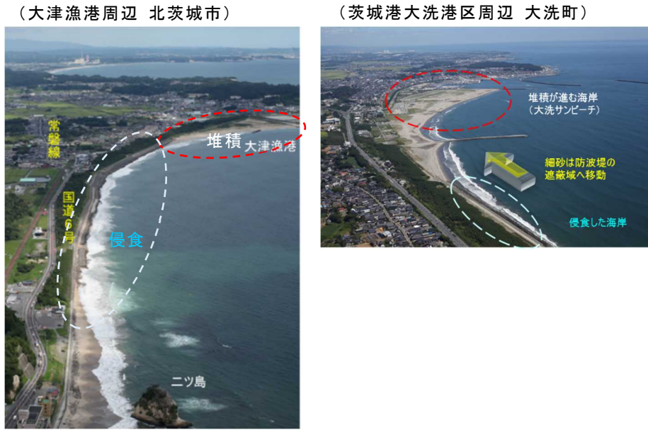
写真 2.8 大規模構造物周辺の堆砂と侵食
