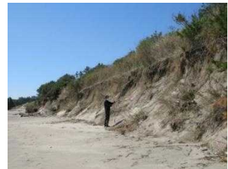
（多賀地区海岸 日立市）
