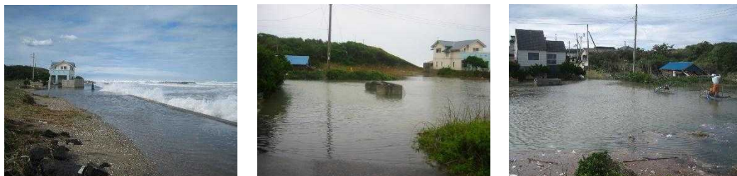
写真 2.6 大洗港最高潮位時の越波、浸水状況
