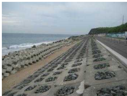
写真 2.23 消波ブロックが置かれた海岸
