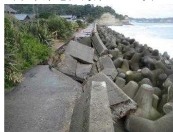
図 2.15 茨城沿岸の海岸堤防の築年数と海岸保全施設の老朽化
