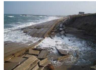
（荒野地区海岸 鹿嶋市）
