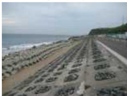
写真 2.22 消波ブロックが置かれた海岸
