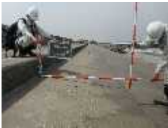
■堤防点検 計測 （下津地区海岸 鹿嶋
