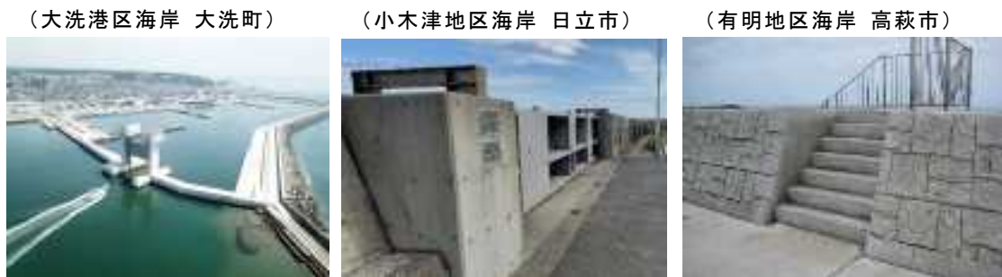
写真 3.10 水門・陸閘および乗り越しタイプ階段の整備例
