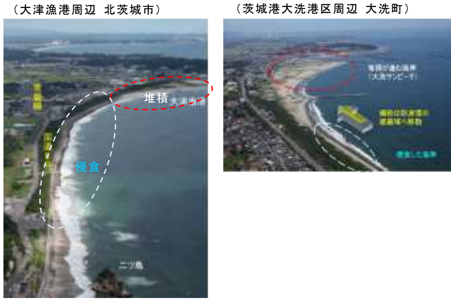
写真 2.8 大規模構造物周辺の堆砂と侵食
