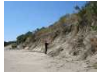
（多賀地区海岸 日立市）
