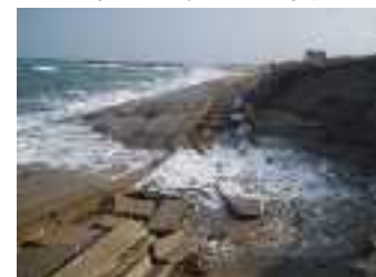
（荒野地区海岸 鹿嶋市）
