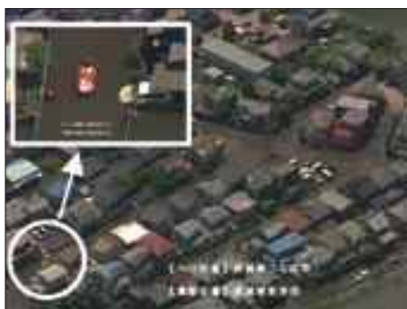
取手市双葉地区の浸水状況 (取手市：双葉地区)
