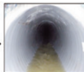
改築後の下水道管
