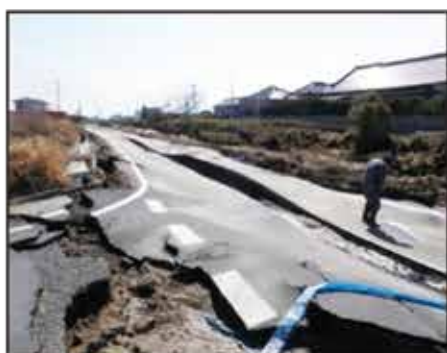
液状化による道路のうねり (鹿嶋市)
