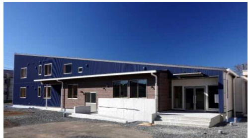
水戸聾学校寄宿舎宿泊棟改築工事
