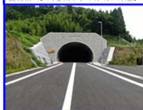
整備後（下高倉側トンネル坑口付近）
