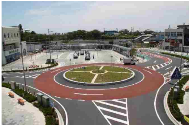
▲駅前広場にラウンドアバウトを整備して交通円滑化を達成した事例(常陸多賀駅)
