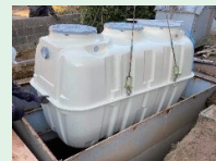
高度処理型浄化槽の設置
