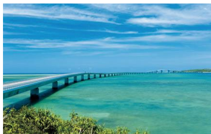
伊良部大橋(宮古島市)
