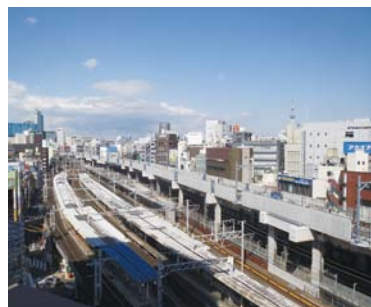
上野東京ラインの線路(右側の高架橋)
