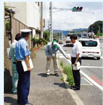
緊急合同点検の様子
