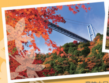
竜神大吊橋(常陸太田市)
