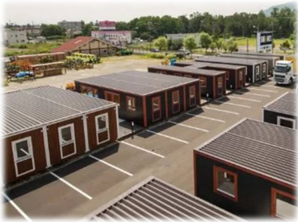
トレーラーハウスを連結
