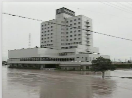
那珂川氾濫(旧水戸プラザホテル)
