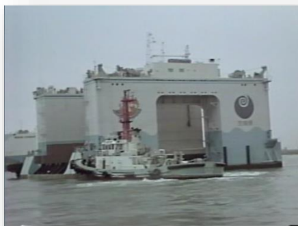
建設中の常陸那珂港大型ケーソン
