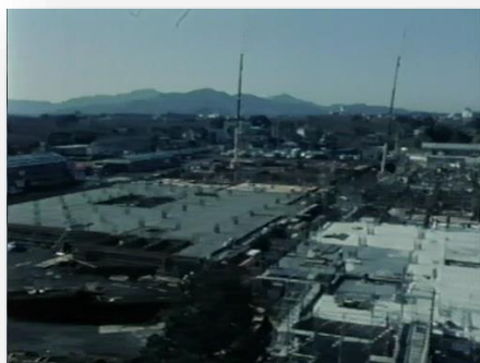
建設中の県立中央病院新館
